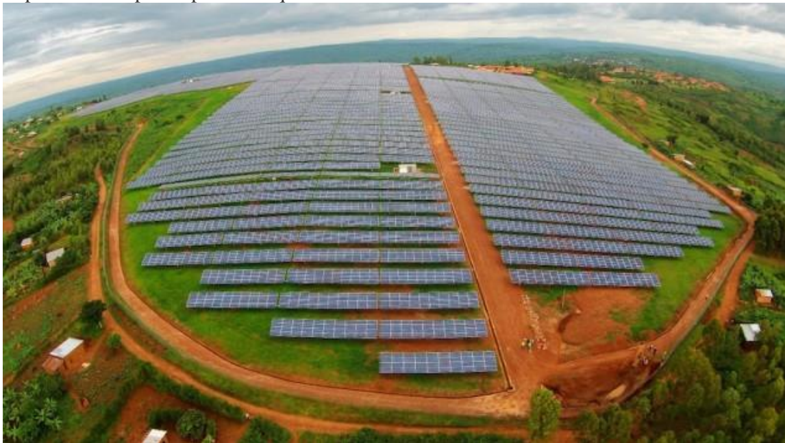
Le projet solaire de Gigawatt Global au Ruanda (Courtesy)
