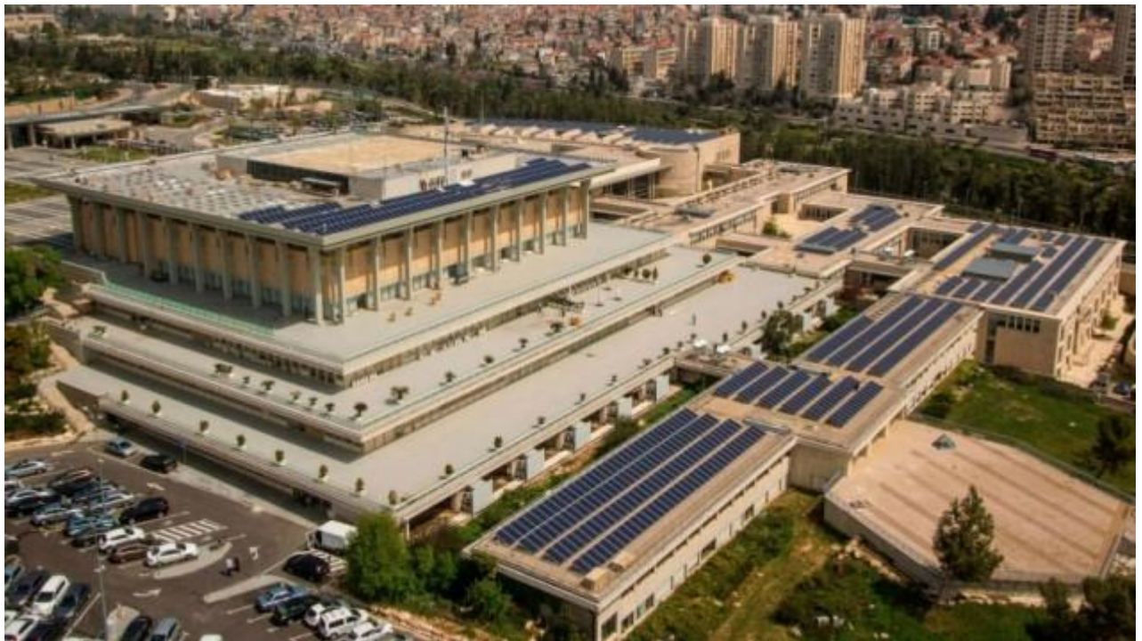
Central solaire que les toits de la Knesset, élément du projet « Knesset verte »
